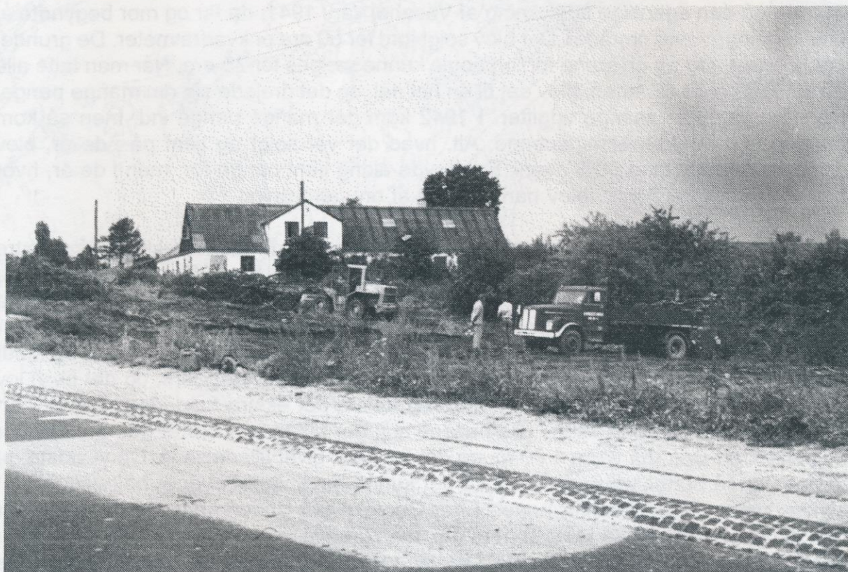
Syvendehusvej er etableret. Tilhøjre i billedet ligger nu rækken af ens Høm-huse.
