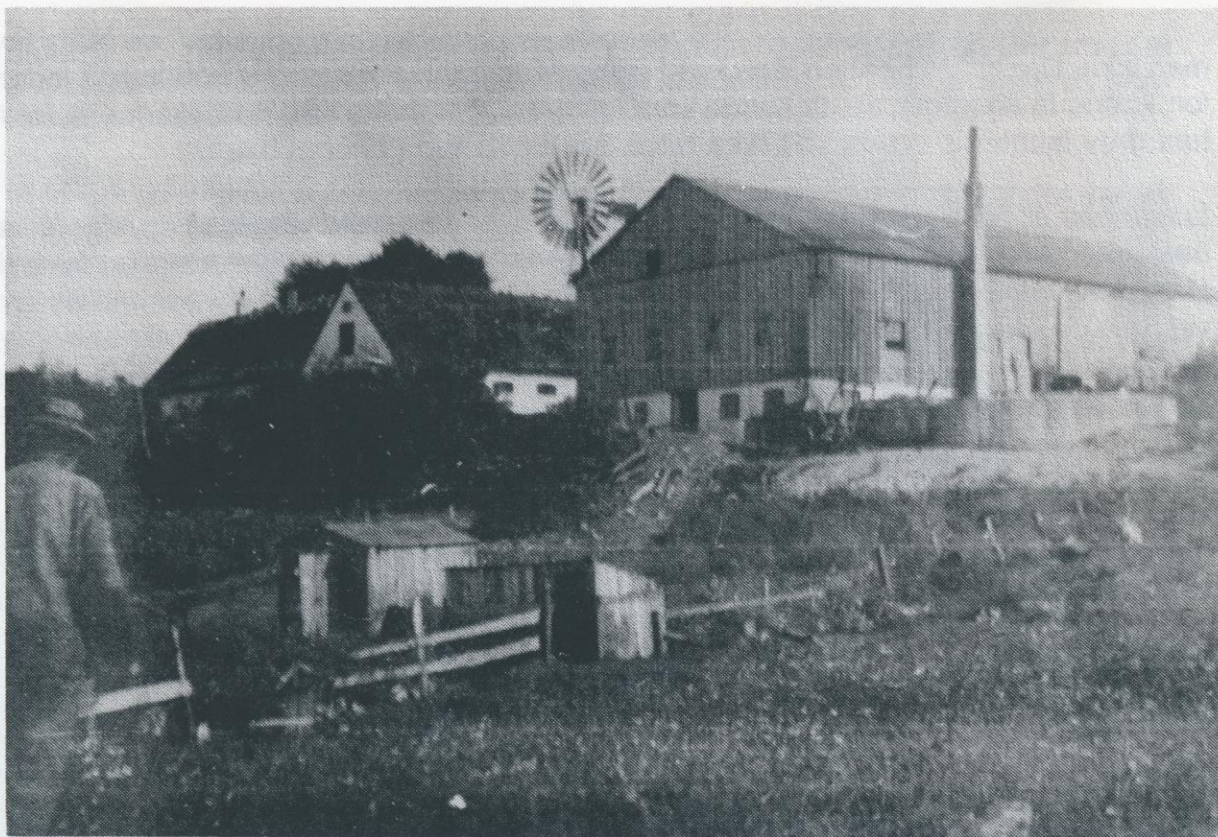
Den ældste lade, set fra nord. Senere blev den anden lade bygget til, vinkelret på. Skorstenen er fra kogeriet, kedlen stod i kælderen. Foran ses den store runde ajlebeholder.
